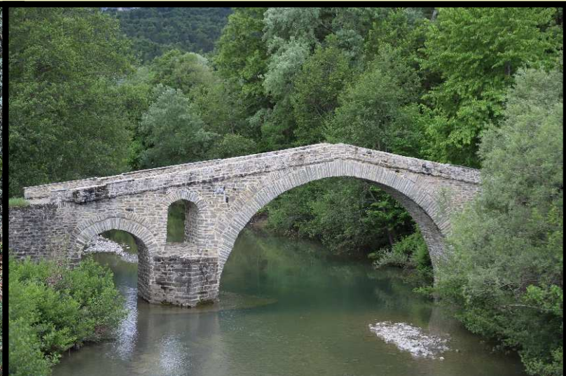
mittelalterliche Steinbrücke im nordwestlichen Epirus
